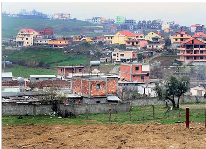
(Në foto) Ndërtime pa leje (foto ilustruese)
